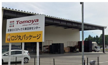
ロジ丸パッケージ 第四倉庫
