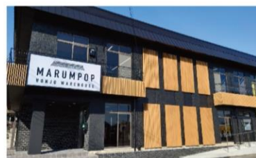
ロジ丸パッケージ 第三工場 HONJO WARE HOUSE
